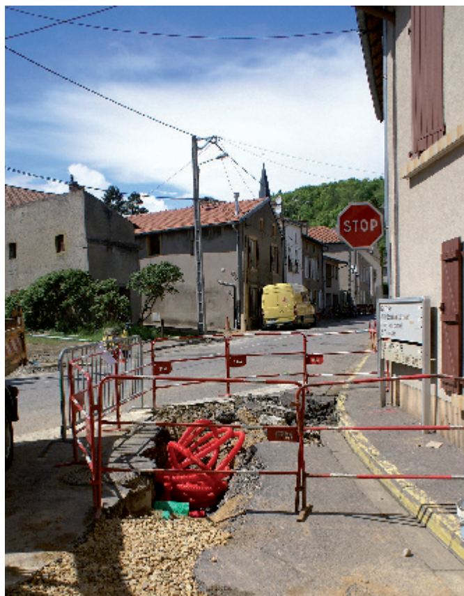
Travaux rue de Verdun
