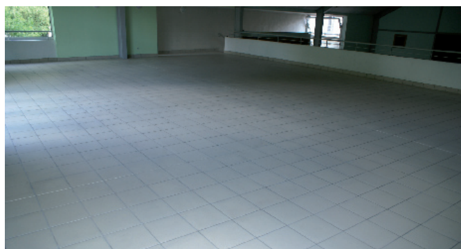
Réfection du carrelage sur la mezzanine du centre
