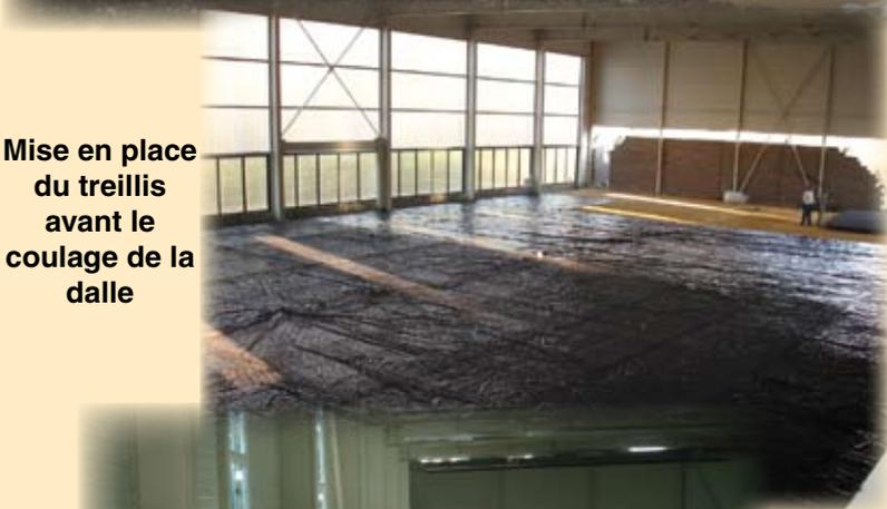
**Mise en place du treillis avant le coulage de la dalle**
